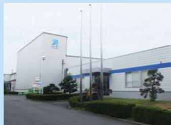
事務所及び工場建屋
