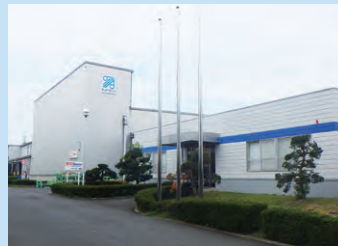
事務所及び工場建屋
